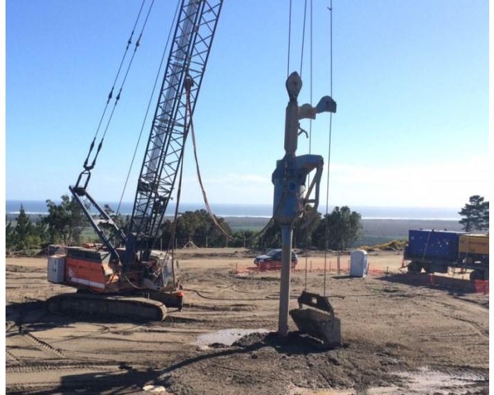
Foto 2– Ejecución Columnas de Grava.
