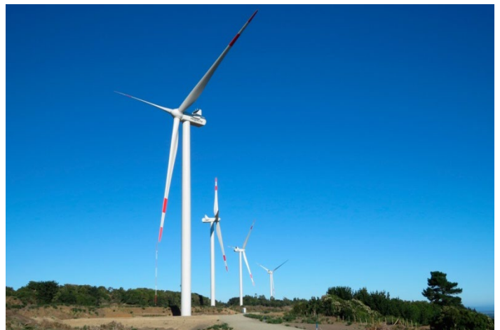
Foto 4 – Torres eólicas en funcionamiento.
